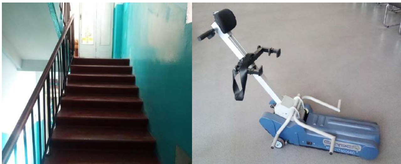
Лестница (внутри здания)
