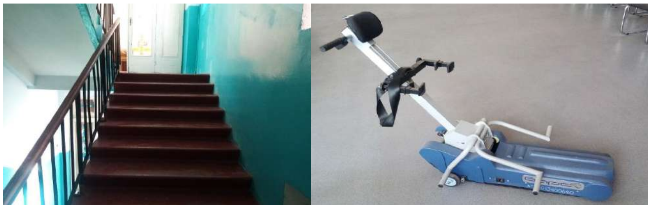
Лестница (внутри здания)
