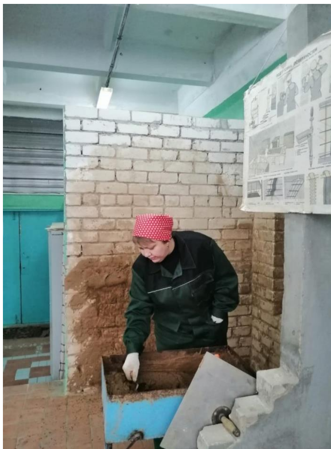
Рисунок 4 – Демонстрация приемов набрасывания раствора на поверхность
